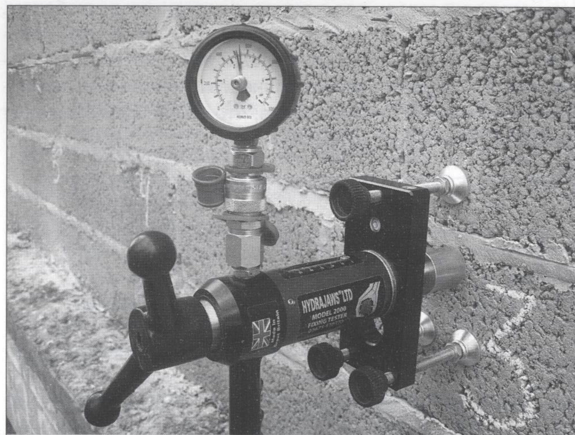
Рис. 1. Испытание анкера на объекте
